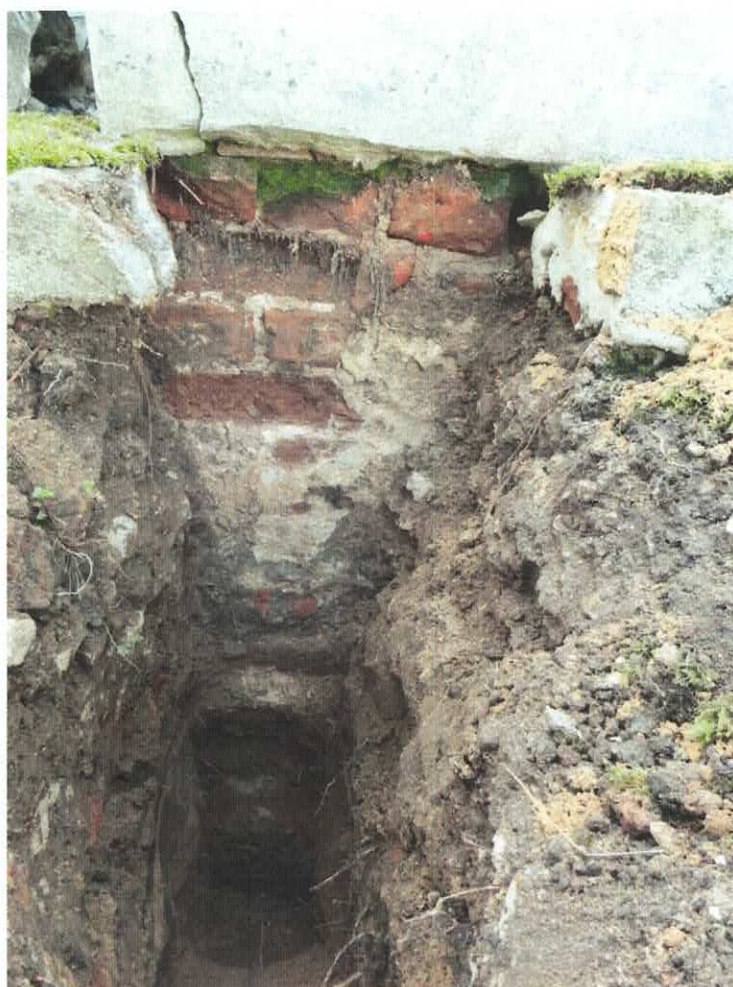
Fot. 12. Odkrywka fundamentu (mur z cegły pełnej)
