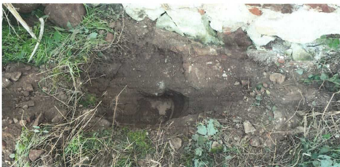
Fot. 11. Odkrywka fundamentu (mur mieszany)
